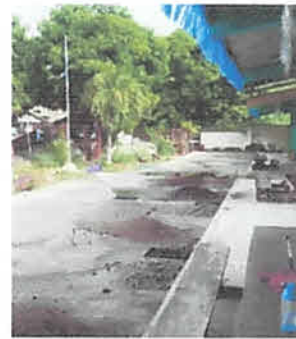
Foto 2: Realización de cimientos de cemento y barilla para los muros que sostendrán la galera.
