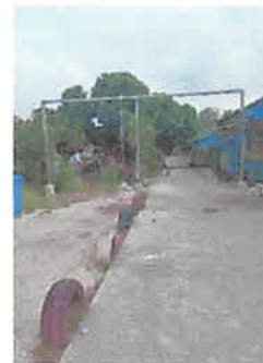
Foto 4: Montaje de bases y estructura de metal que sostendrán la construcción de la galera.
