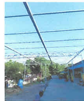
Foto 6: Armadura de metal terminado para el techado de la galera.
