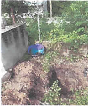
Foto 1: Inicio de excavación de agujeros que sostendrán los muros de la galera.
